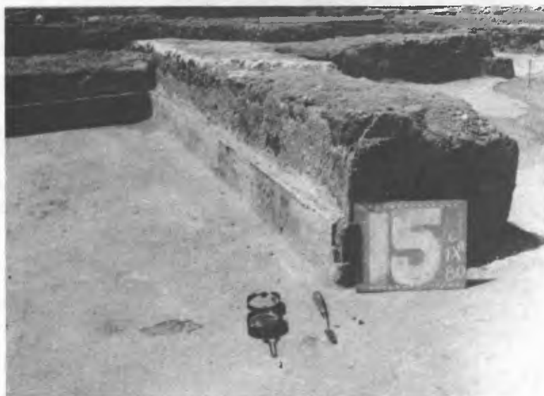
Foto 10.- Un elemento de construcción presente comúnmente en las residencias es el “zoclo o chaflán”, en la base de los muros.
