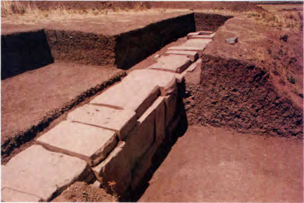
Foto G. Vista de la técnica constructiva del canal de drenaje (rasgo 1) de la cima oeste.
